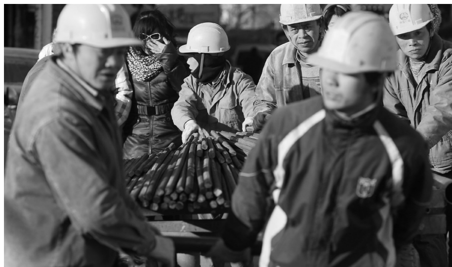
Indvandrede landarbejdere på bygningsarbejde i Beijing. De kunne måske godt strejke, men er de arbejdere eller stadigvæk bønder?
